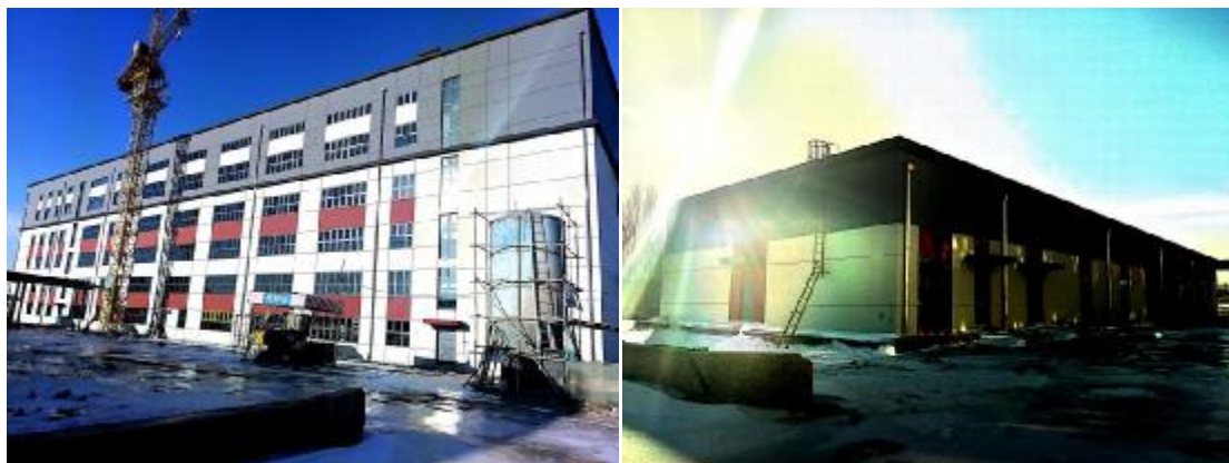
图2.6-1 项目区现场照片
